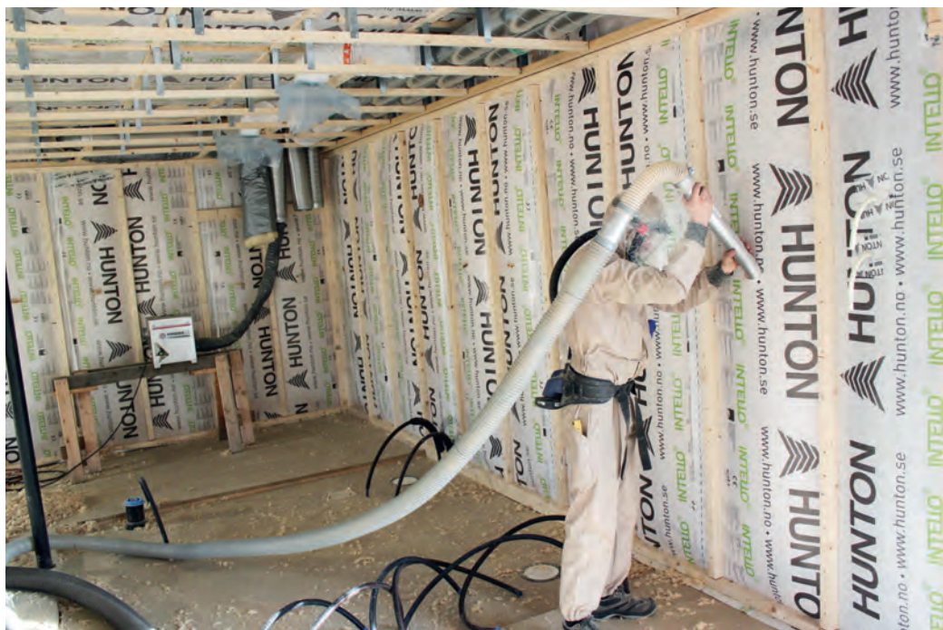
BLÅSER. Norsk Trefiberisolering satser mye mot nyboligmarkedet. På bildet blåseisolerer de et hus på Gjøvik som blir bygget i regi av Nordbohus.
